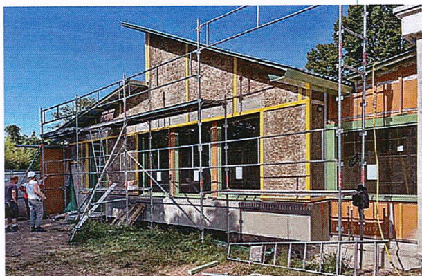
Bâtie sur un socle en béton brut, la nouvelle construction est constituée d'une ossature bois remplie de béton de chanvre.
